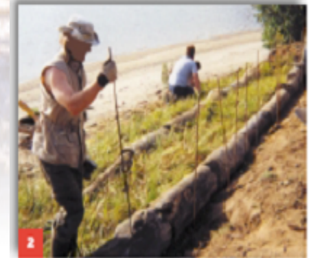
Fixation des billots à l'aide des tiges de métal. Les tiges sont insérées dans des trous faits avec une perceuse.
