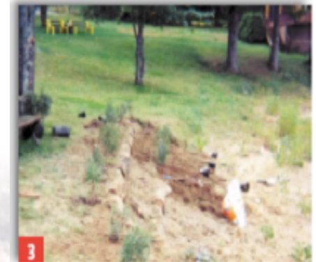
Plantation des arbustes de part et d'autre des billots et incorporation de la terre noire et de la terre en place aux plants. La motte des racines des arbustes est enveloppée de jute afin de contenir la terre la première année (selon le site).
