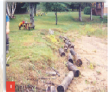
Reprofilage de la berge à la pelle afin d'adoucir la pente et disposition en continu des billots de bois.
